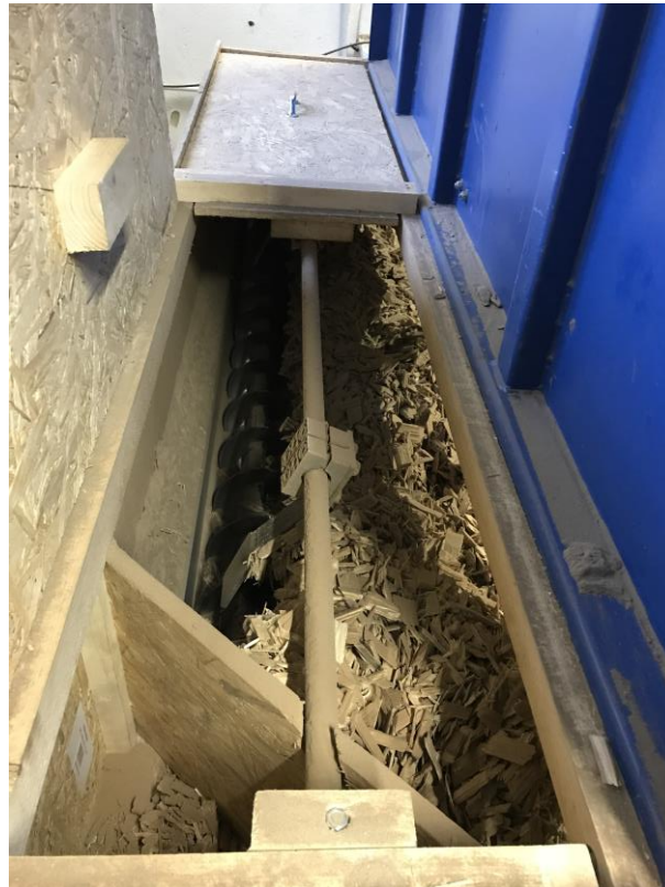
Abbildung 1-21: Übergabetrog zwischen Schubbodencontainer und Schneckenfördersystem
