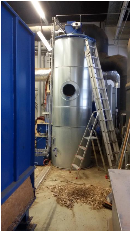
Abbildung 1-18: Biomassetrocknungsanlage nach Abbau des Kratzkettenförderers, Trommelfilter und Abluftrohrleitungen
