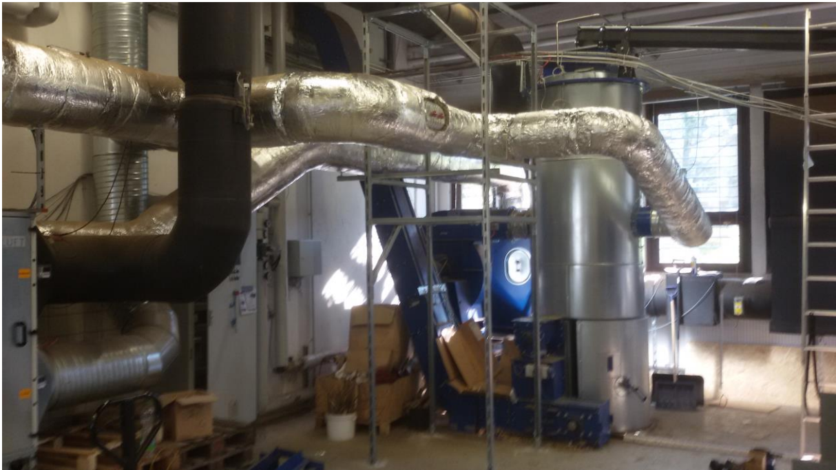
Abbildung 1-20: Lastengerüst und neu installiertes Abluftrohr zwischen Silotrockner und Wärmerückgewinnung
