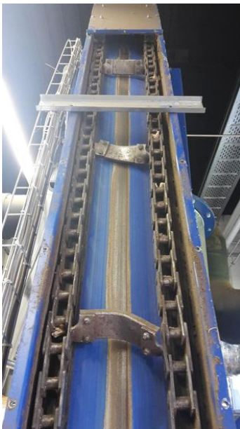
Abbildung 1-14: verbogene Mitnehmer des Kratzkettenförderers
