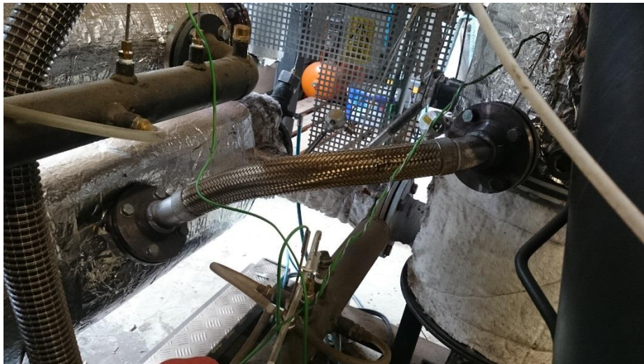
Abbildung 1-52: Bisherige Vergasungsluftzufuhrstrecke zwischen „Gas-Gas-Wärmeübertrager“ und Reformier
