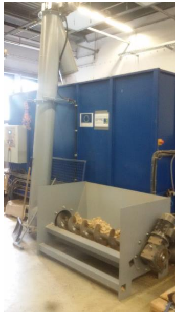
Abbildung 1-6: Holzhackschnitzel-Transportsystem zur Befüllung des Schubbodencontainers
