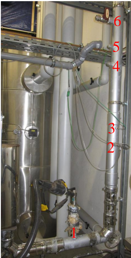
Abbildung 1-4: Neu installierte und durch weitere Messstutzen ergänzte Motorabgas-Messstrecke
