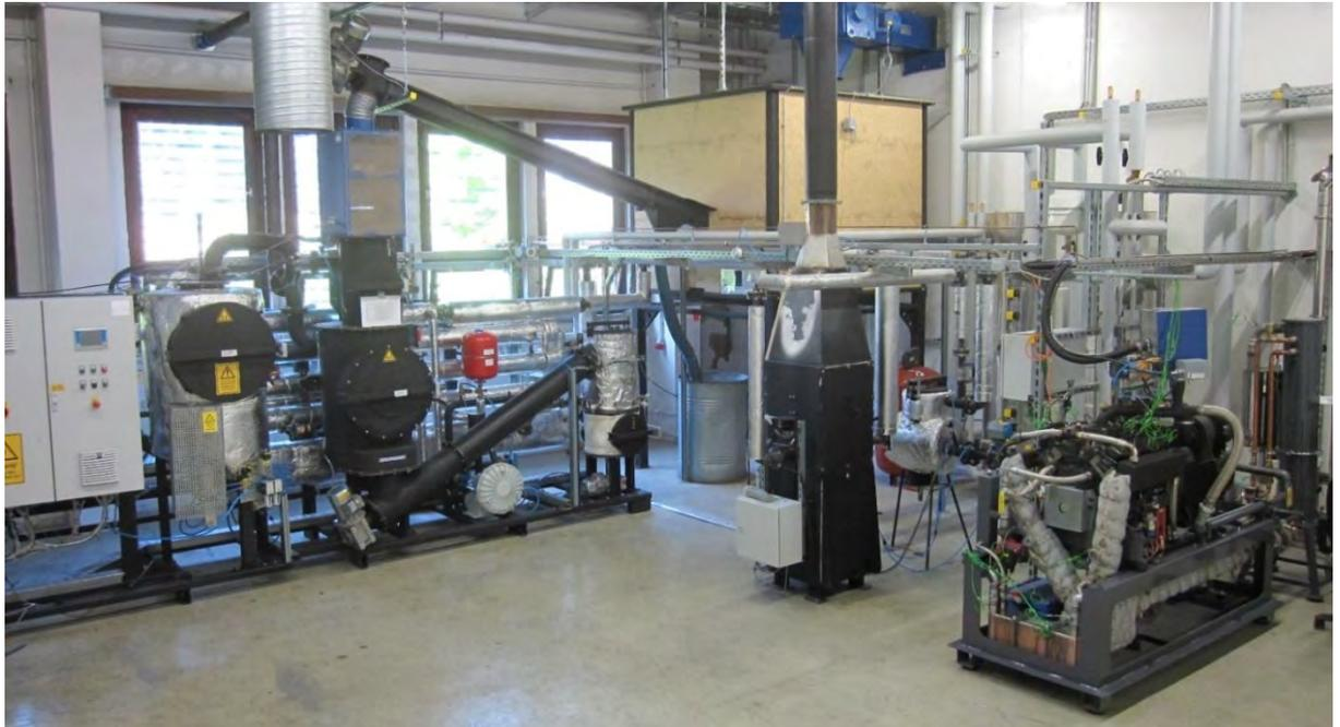
Abb. 4-26: Übersicht des Holzgas-Blockheizkraftwerks
