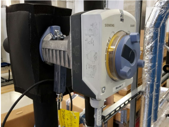
Abbildung 2-11: Mischventil mit Stellantrieb und Spindelheizung Kältespeicher
