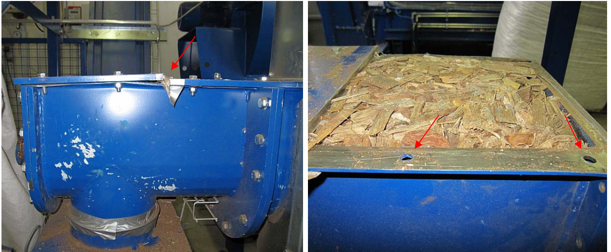
Abbildung 6-2: Defekte Ausförderschnecke durch verdichtete Holzhackschnitzel
