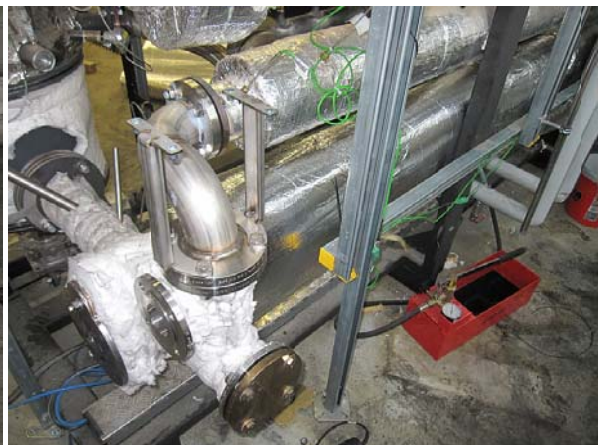
Abbildung 2-33: Installierter Nachreformer II
