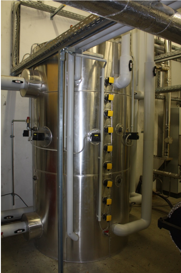
Abbildung 2-18: Pufferspeicher TCV II; Volumen 2200 l, gelb: Temperaturfühler GLT, schwarz: Heizpatronen 5x6 kW
