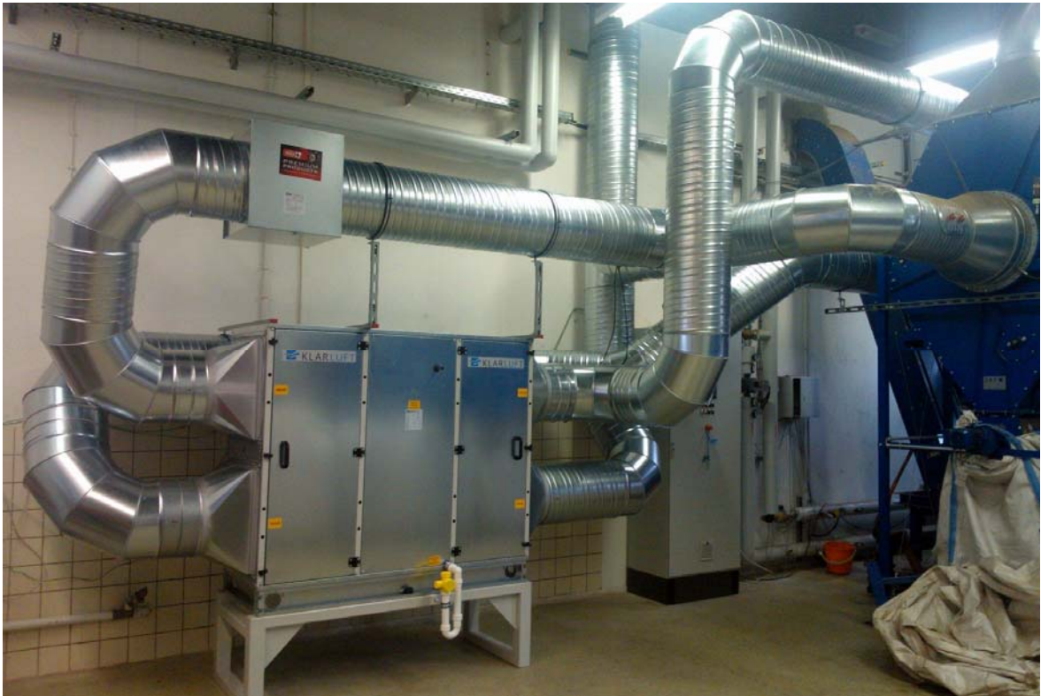
Abbildung 2-23: Wärmerückgewinnungseinheit (noch unisoliert) als Komponente des Versuchsstandes Biomassetrocknung
