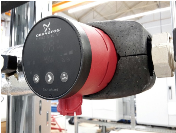
Abbildung 2-13: Umwälzpumpe Sekundärkreislauf
