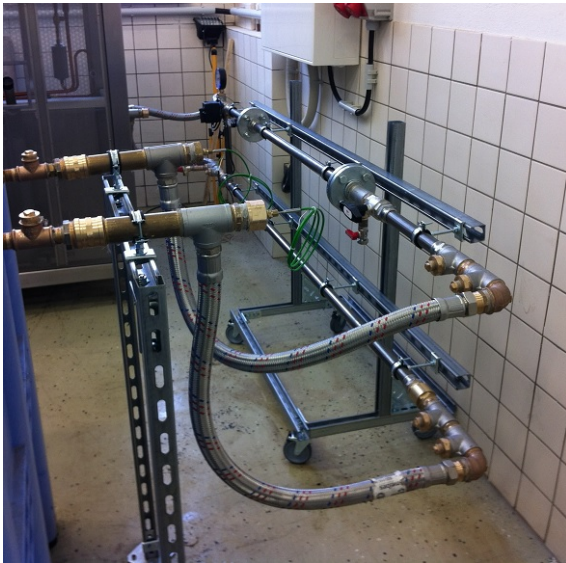
Abbildung 2-4: Hydraulische Verschaltung zwischen Temperiergerät (im Hintergrund) und Paraffinspeicher mit Temperatursensorik
