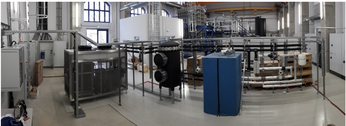
Abbildung 2-42: Versuchstand TCV I am Standort Zittauer Kraftwerkslabor
