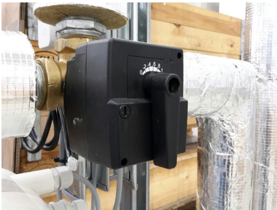
Abbildung 2-12: Mischventil mit Stellantrieb Wärmespeicher
