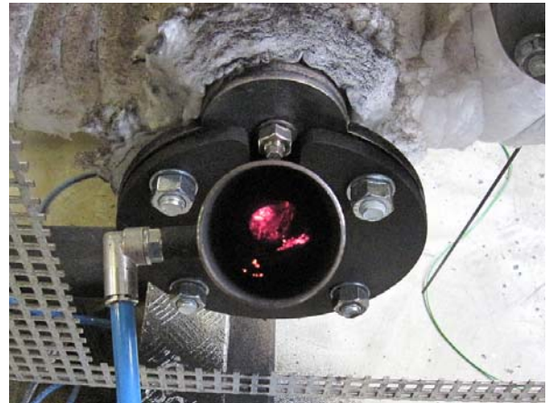
Abbildung 2-35: Brennkammer Nachreformer im Betriebszustand
