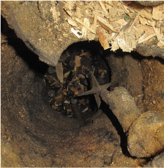
Abb. 8-14 Reformerinnenansicht nach manueller Entleerung bis zur Luftdüsenebene
