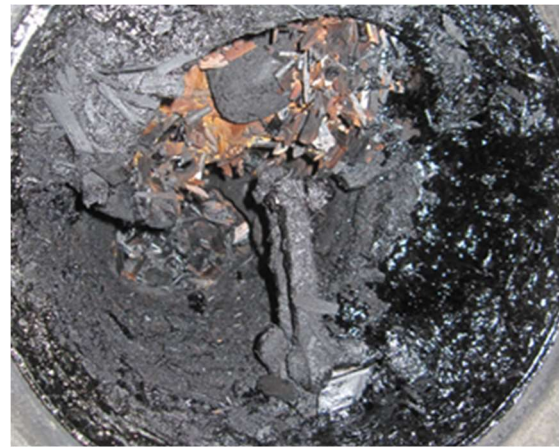
Abb. 8-13 Innenansicht Reformer nach GR3
