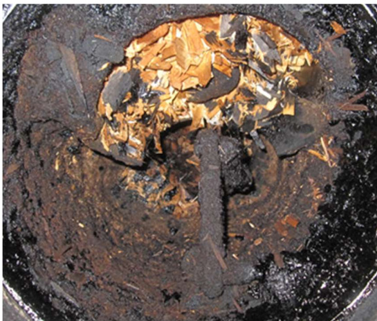
Abb. 8-11 Innenansicht Reformer nach GR1
