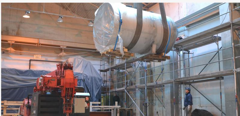
Einheben des Abblasebehälters über das Dach
