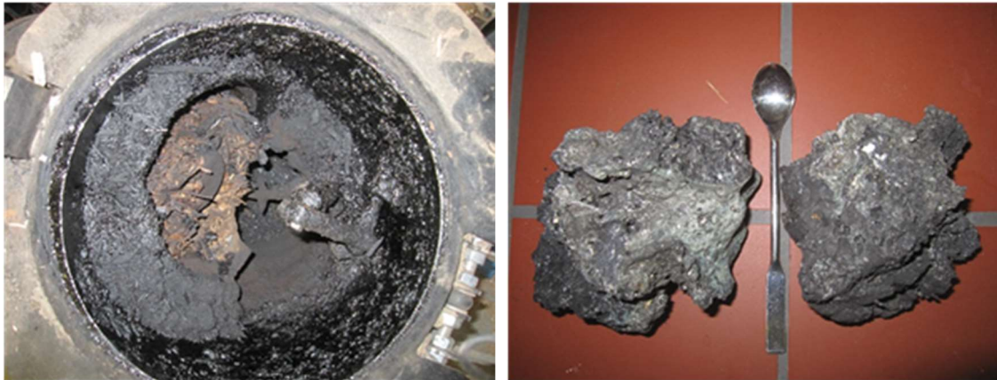
Abb. 2-35 Nach Einsatz der Siebüberlauf-HHS; links: Blick von oben in den Reaktor; rechts: aus dem Reaktor entfernte Schlackebrocken
