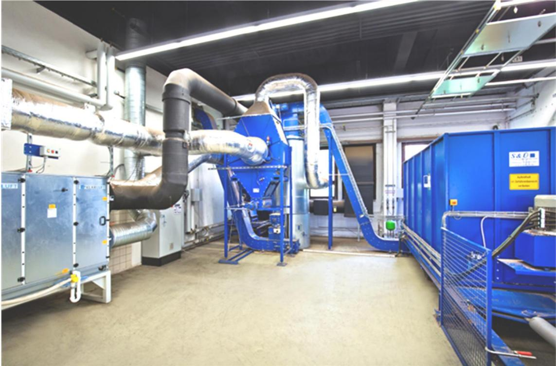
Abb. 4-24 Trocknungsanlage für Holzhackschnitzel
