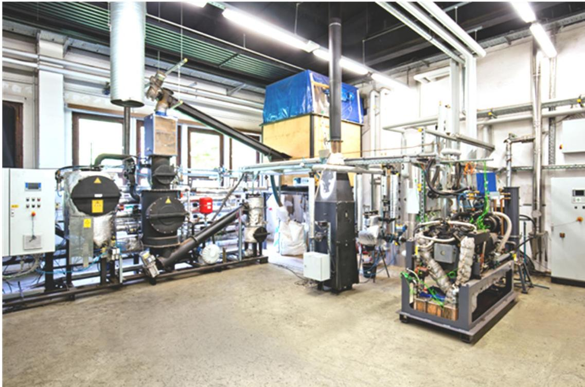
Abb. 4-23 Übersicht des Holzgas-Blockheizkraftwerks
