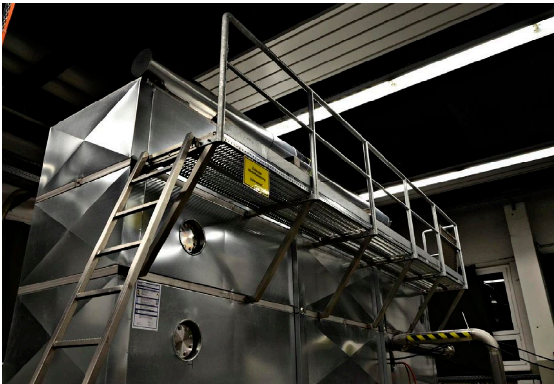
Abbildung 7: Der Wannenbehälter der Zittauer Strömungswanne (ZSW)
