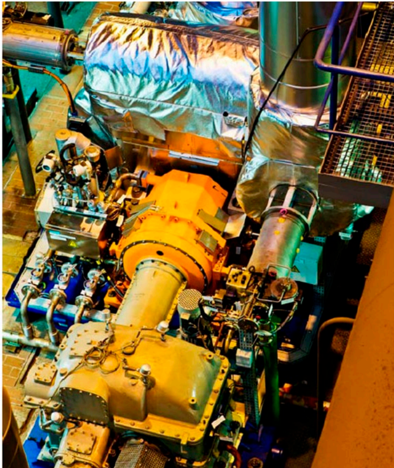
Abbildung 1: Magnetgelagerte Speisepumpenantriebsturbine im Kraftwerk Jänschwalde
