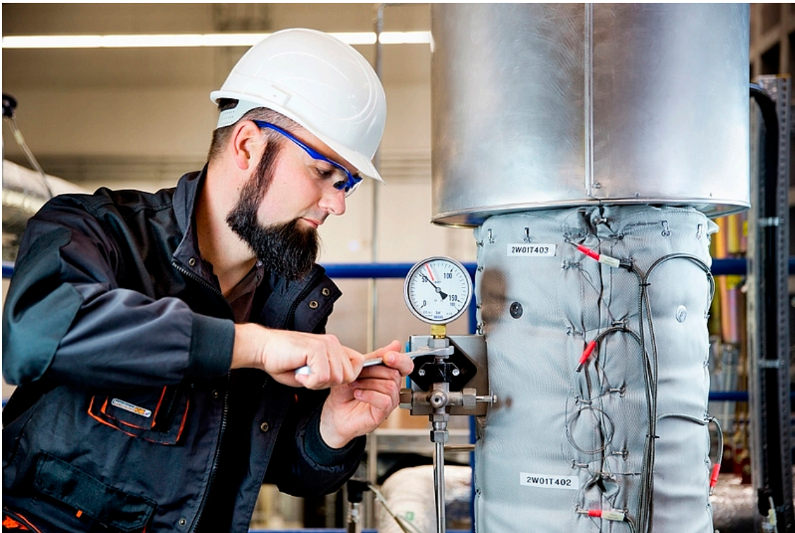
Abbildung 46: Torsten Klette während Wartungsarbeiten an einer Druckarmatur
