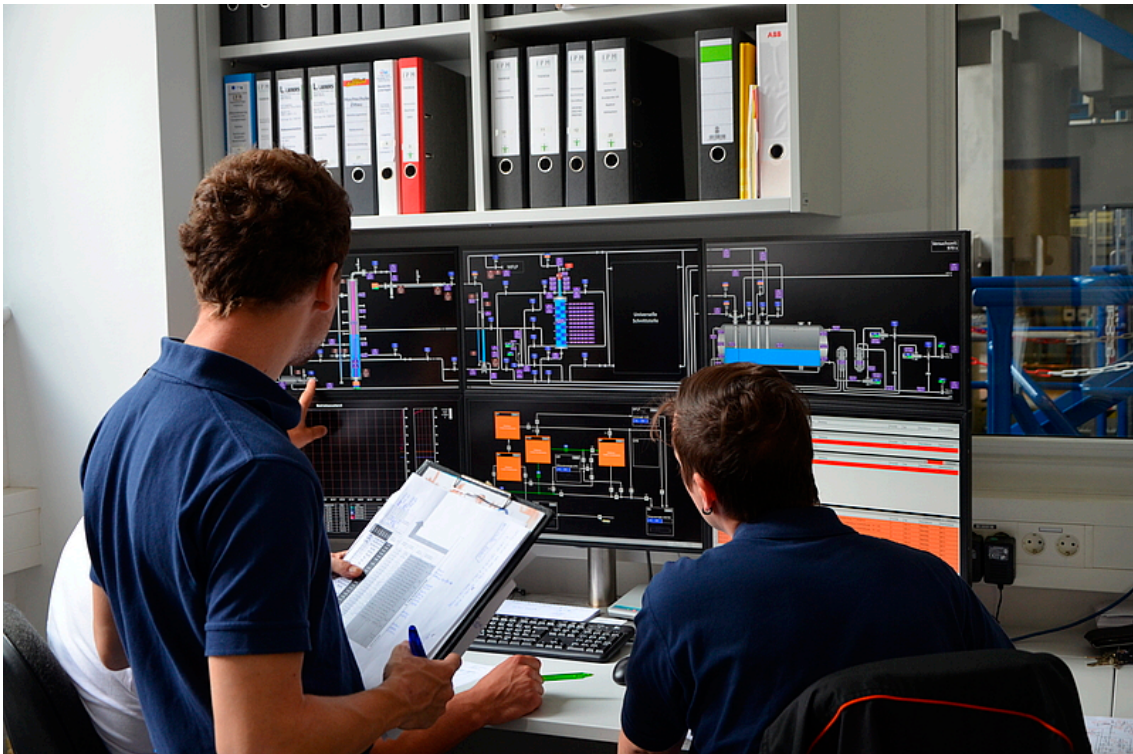
Abbildung 32: Abnahme der Leittechnik durch die Mitarbeiter der Zuständigen Überwachungsstelle (TÜV Süd)
