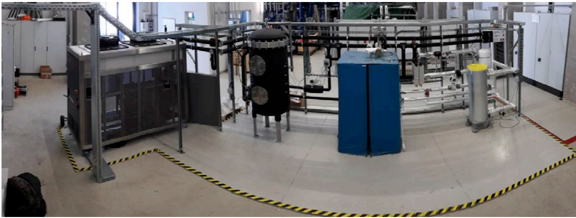
Abbildung 24: Testfeld für Wärmespeicher
