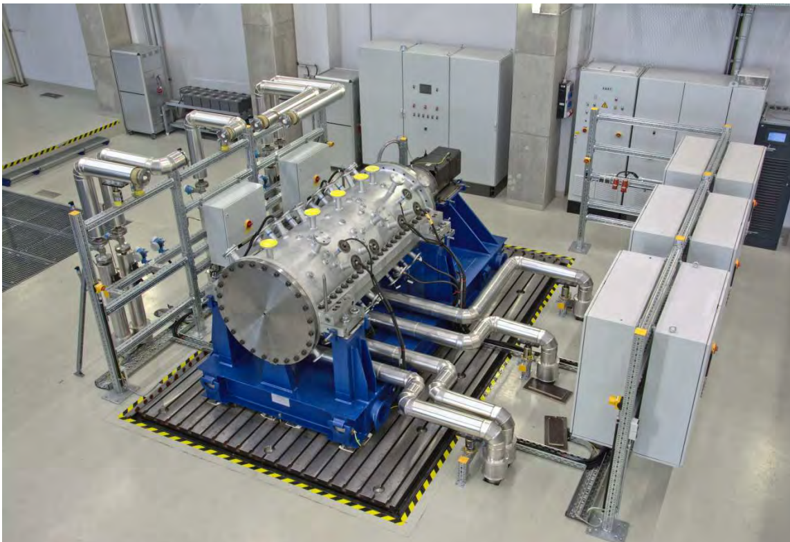
Abbildung 1: Versuchsanlage Magnet- und Fanglagerprüfstand MFLP im Zittauer Kraftwerkslabor
