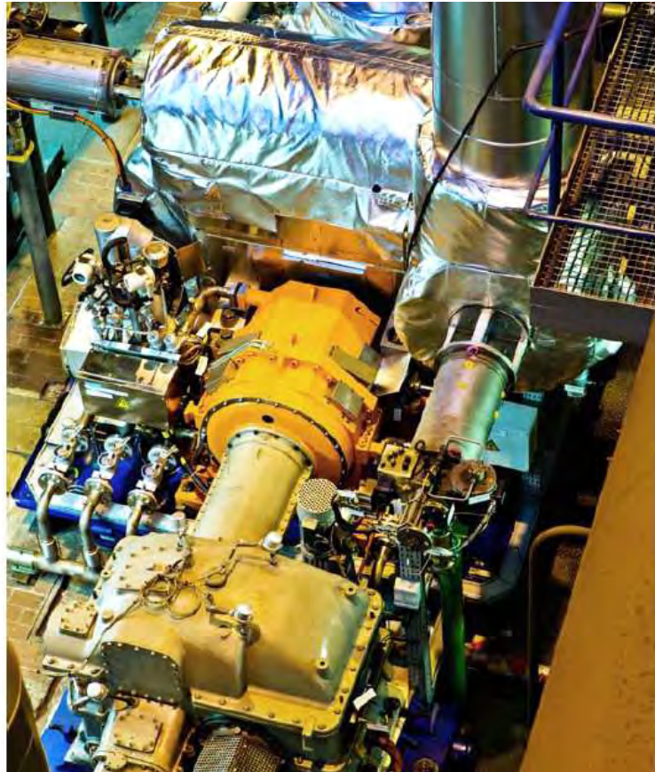
Abbildung 3: Magnetgelagerte Speisepumpenantriebsturbine im Kraftwerk Jänschwalde
