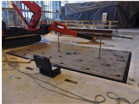
**Abbildung 4: Einheben und Ausrichten der Aufspannplatte**
