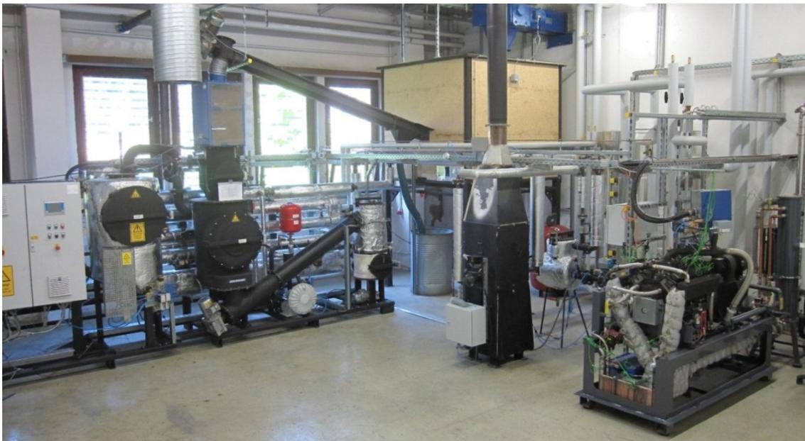
**Abbildung 33: Übersicht des Holzgas-Blockheizkraftwerks**
