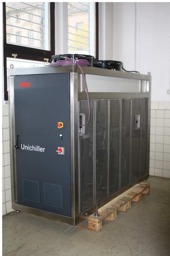
Abbildung 31: Temperiergerät (Huber Unichiller)
