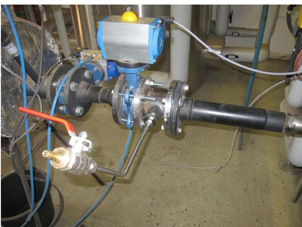
Abbildung 3-8: Messstelle MS3 (Produktgas vor Motor)
