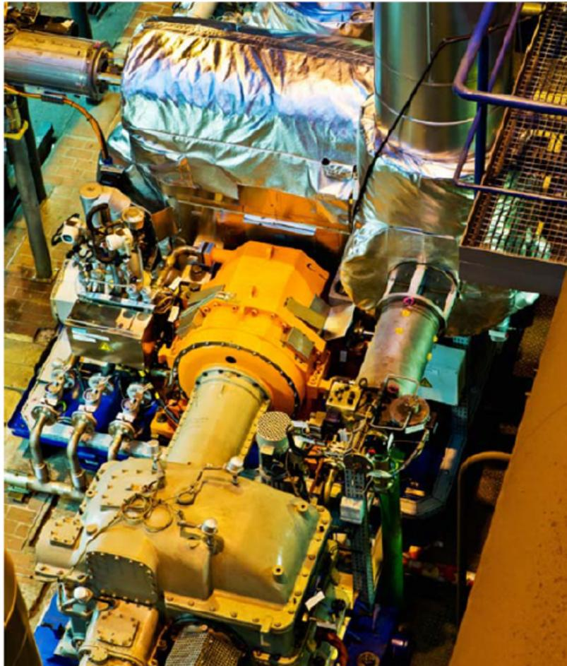
**Abbildung 1: Magnetgelagerte Speisepumpenantriebsturbine im Kraftwerk Jänschwalde**
